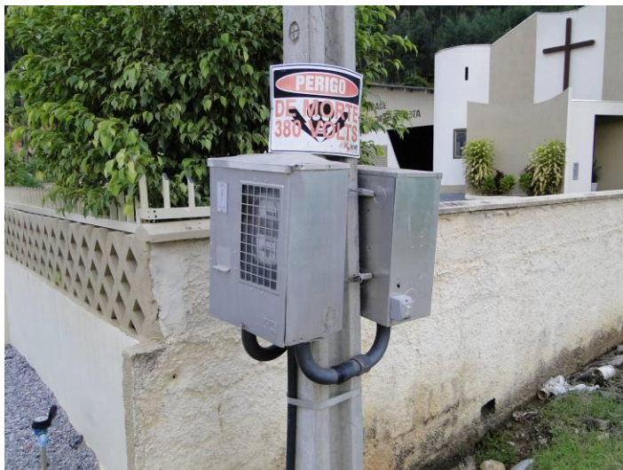
Figura 8– Captação de água bruta em poço profundo – Comunidade Pedras Grandes. Fonte: Visita Técnica STE, 2010.
