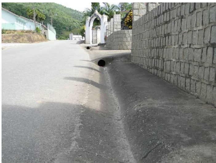
Figura 43– Drenagem superficial - sarjeta Fonte: Visita Técnica STE, 2010.
