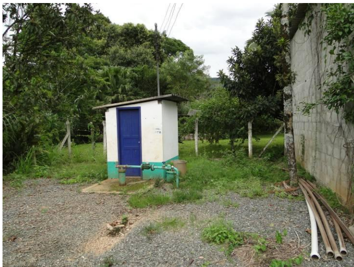
Figura 17– Captação de água bruta em poço profundo da CASAN – Sede do Município. Fonte: Visita Técnica STE, 2010.
