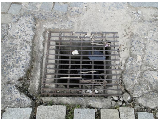
Figura 41– Boca de Lobo tipo grelha Fonte: Visita Técnica STE, 2010.
